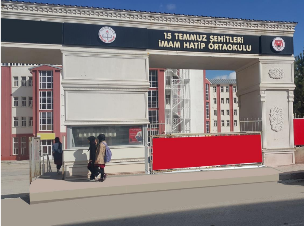
Okul Girişi (Ön Cepheden Görünüm)
