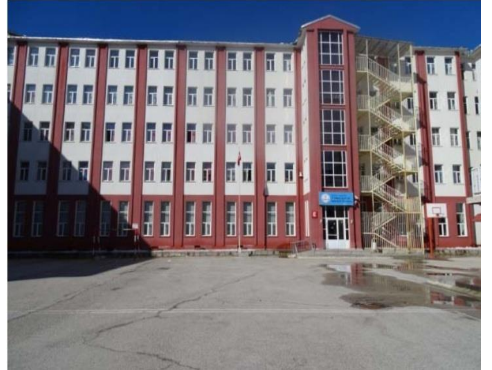
Okul Bahçesi (Ön Cepheden Görünüm)
